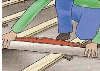
Vérification de la planéité de manière régulière.
