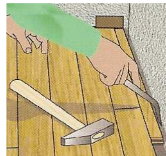
La dernière lame est placée grâce à un tire-lame et est clouée en pleine planche.
